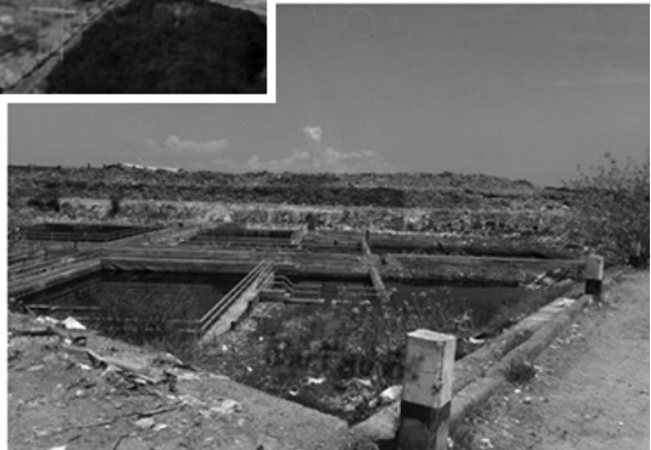
Foto 5. Sanitary Landfill TPA Sumber: Google
