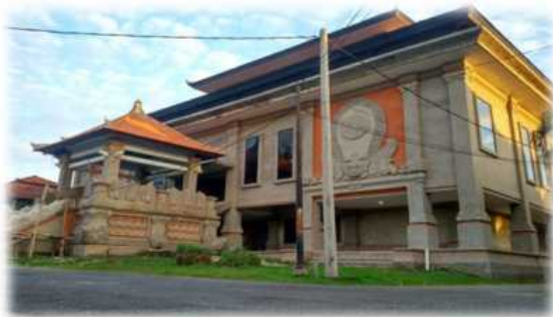
Gambar 8.71 Pembangunan Gedung Auditorium, tampak samping
