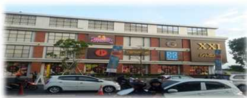
Gambar 8.81 Level 21 tampak luar
