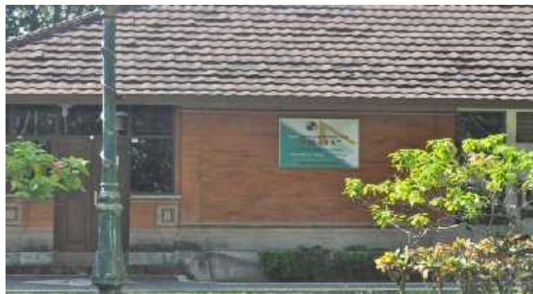
Gambar 8.57 Gedung Koperasi Kantor Gubernur Bali
