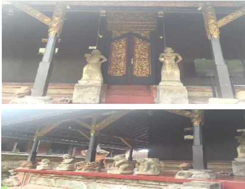
Gambar 8.9 Pintu masuk Gedung Buleleng
