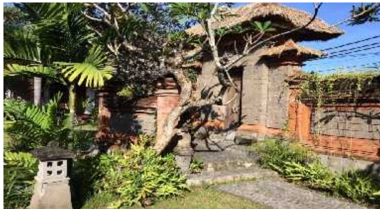
Gambar 8.84 Pintu masuk Hotel Bumaz
