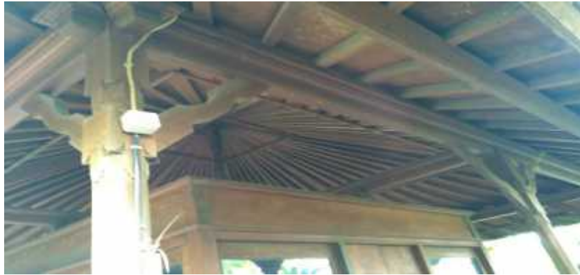
Gambar 8.49 Rangka Atap
