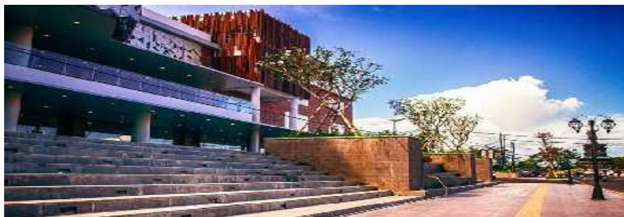
Gambar 8.80 Tangga keluar masuk gedung Plaza Renon
