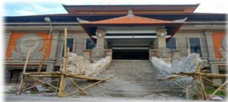
Gambar 8.70 Pembangunan Gedung Auditorium, tampak depan
