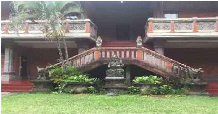
Gambar 8.15 Tampak Depan Gedung Timur
