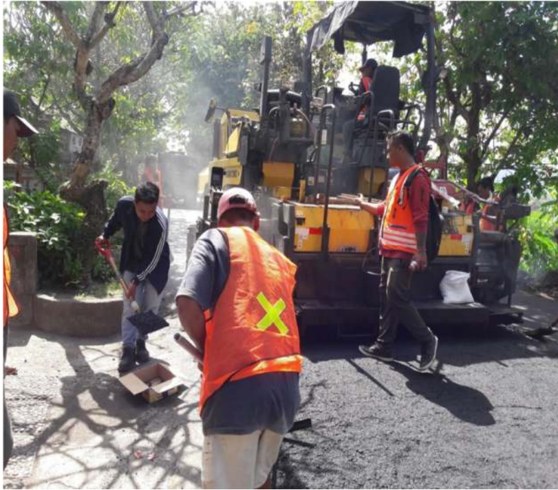
Lampiran F3: Pengambilan sampel aspal dibelakang Finisher
